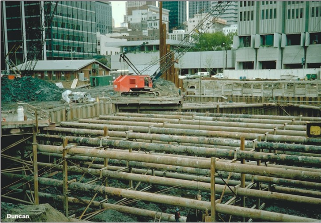
Figure 1.8 : Détail de butons
